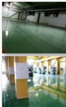
Свойства бетонного основания и методы подготовки его поверхности должны соответствовать действующим строительно-техническим нормам. Основание должно быть прочным, однородным, чистым, сухим, свободным от масел, жиров, крошащихся участков, отслаивающихся остатков старого покрытия и прочих загрязнений, препятствующих адгезии.
