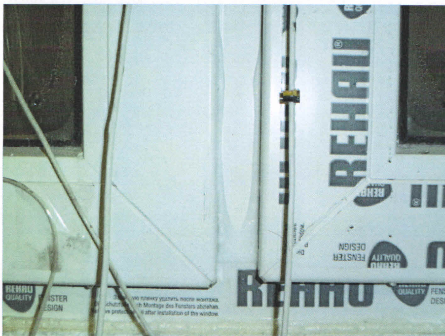
Рис 2 Обмерзание внутренней поверхности рамы в следствии прохождения воздуха сквозь оконную раму ( t_n = -50^{\circ}\text{C} ).
